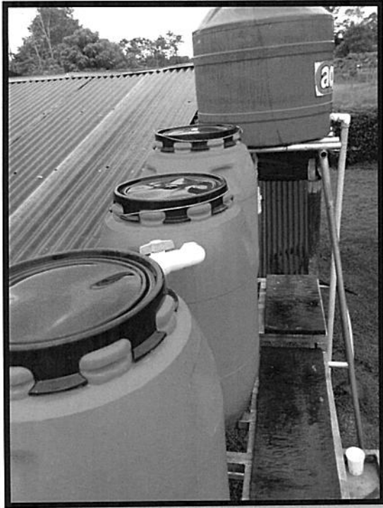
Tanques (filtros) vistos desde la plataforma
